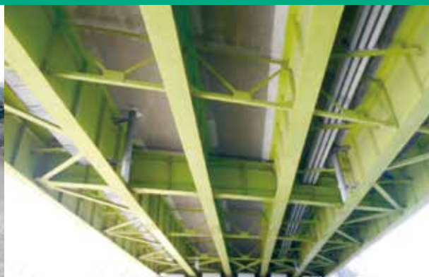
ふれあい市川大橋(20年) 健全性判定区分Ⅱ
