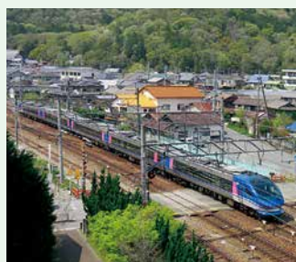
▲駅の橋上化が望まれる
