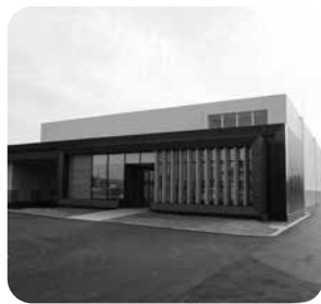
給食センター外観
